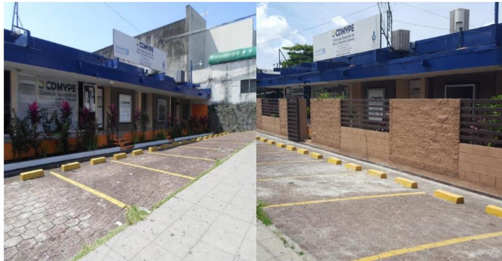
Tramo 3 antes y después de la intervención
