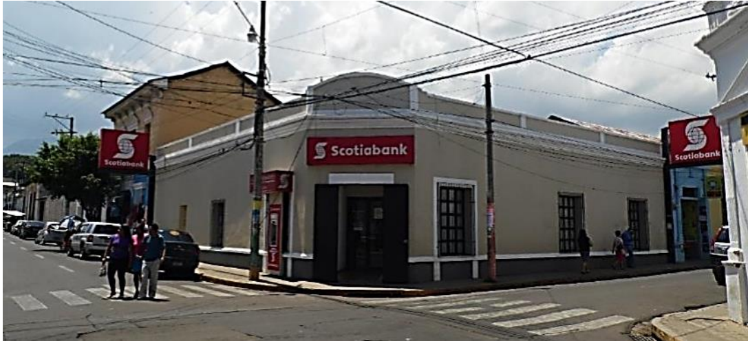
Antes: paredes de adobe con problemas de estabilidad
