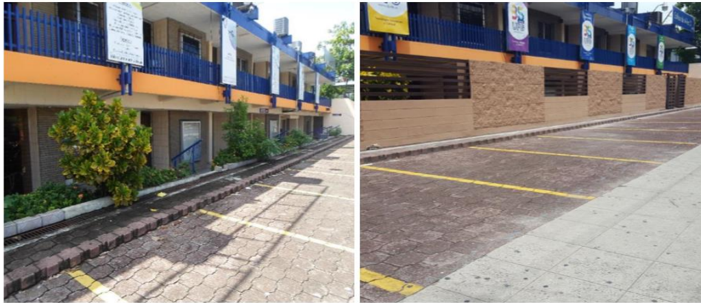
Tramo 1 antes y después de la intervención
