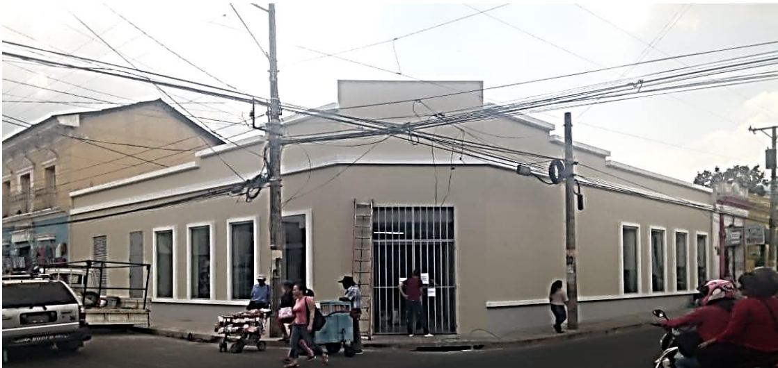
Después: paredes de bloque de concreto
